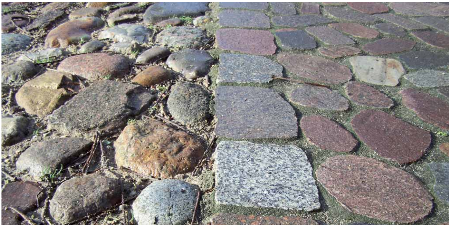
Links ist das unebene Pflaster zu sehen, wie es jetzt um die Pferdeschwemme herum verlegt ist. Rechts dagegen die behandelte Fläche. Der Unterschied ist eindeutig. Leider wird Ammersbek diesen sehr gut begehrbaren und für Gehhilfen und Rollstühle befahreren Mittelstreifen nicht bekommen.
